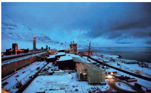
El clima representó uno de los grandes desafíos de la obra. En la zona los vientos alcanzan los 140 km/h y las temperaturas bordean los -2° Celsius. Hubo que emplear módulos prearmados y estrategias constructivas que velaran por la seguridad de los trabajadores.
