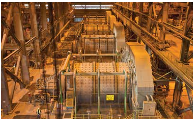
La planta concentradora se encarga de la recepción del mineral enviado por la chancadora primaria y de distribuirla con el brazo radial (stacker) en stockpiles (pilas de mineral) en el exterior de la planta.
