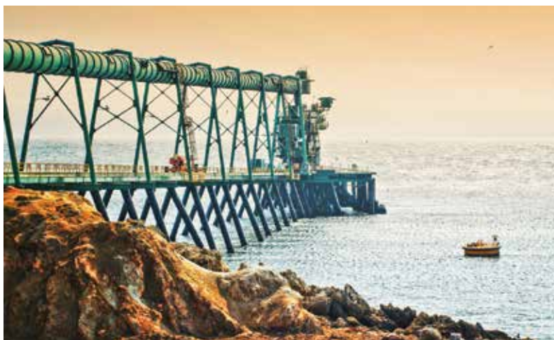
El mineroducto es un tubo metálico recubierto que transporta concentrados de cobre o zinc desde la mina San Marcos) hasta Puerto Punta Lobitos (Huarney).
