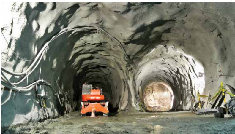
El túnel de conducción está comprendido entre la cámara de carga y la casa de máquinas, con una longitud total de aproximadamente 3.65 km. En la vista se aprecia el cambio de desarrollo de la estructura por la presencia de una falla geológica.
