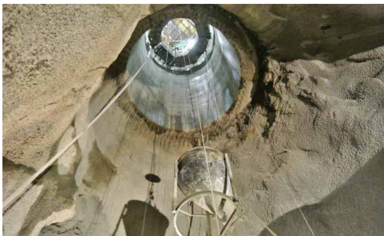
El pique vertical consta de codos superior e inferior que tienen un sostenimiento de pernos de anclaje de 3 m de longitud. Empieza en el nivel 1,635.17 msnm hasta el nivel 1,507.25 msnm, tiene una altura de 127.92 m entre los codos y su diámetro es de 5.20 m.
