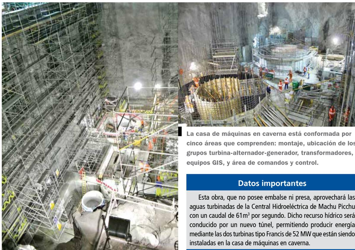
La casa de máquinas en caverna está conformada por cinco áreas que comprenden: montaje, ubicación de los grupos turbina-alternador-generator, transformadores, equipos GIS, y área de comandos y control.
