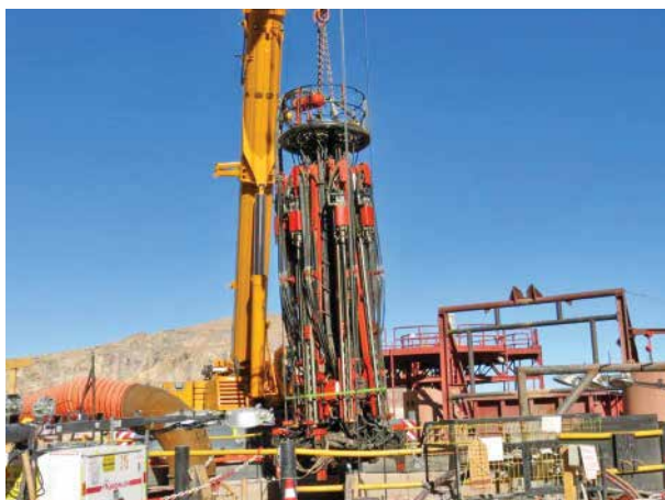
Colocación del jumbo perforador dentro del pique. Este equipo debe bajar cada vez que se realizan las perforaciones en el ciclo; una vez terminada su labor, se sube nuevamente.
