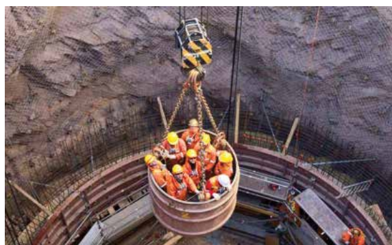
En los primeros metros, los trabajadores ingresaban al pique en el kibble (balde). La labor de la minería de pique requiere multifuncionalidad y rigor. Los procedimientos deben cumplirse sistemáticamente para lograr los objetivos.
