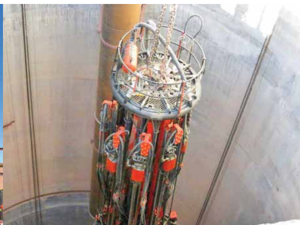
Colocación del jumbo perforador dentro del pique. Este equipo debe bajar cada vez que se realizan las perforaciones en el ciclo; una vez terminada su labor, se sube nuevamente.
