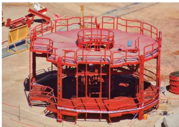
Una parte de la plataforma de trabajo (stage) de cinco pisos y 120 Tn, en la etapa de montaje.
