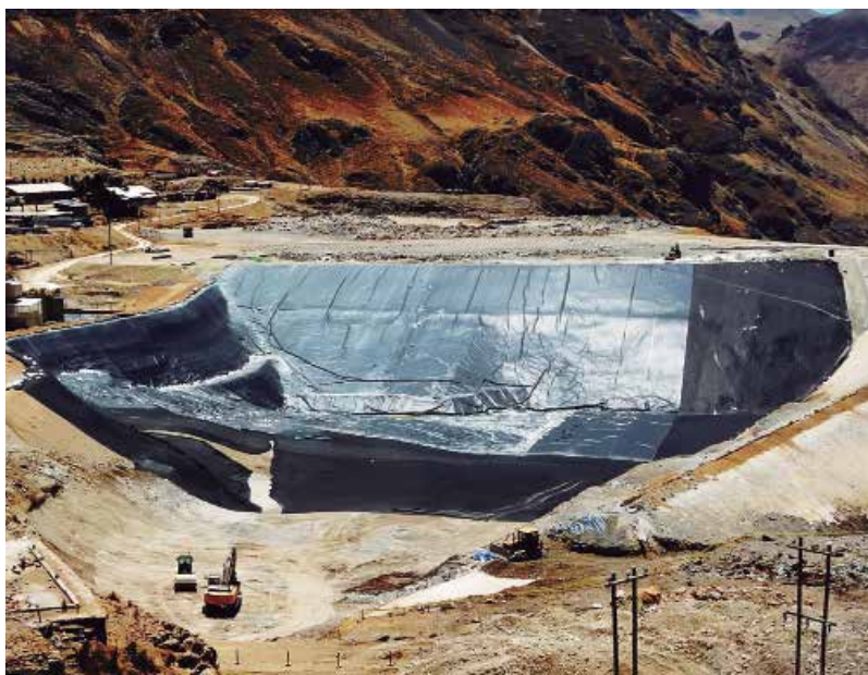
La geomembrana tiene un buen comportamiento tanto en zonas de llano como de altura. Lo importante en estas condiciones es el proceso de instalación.
