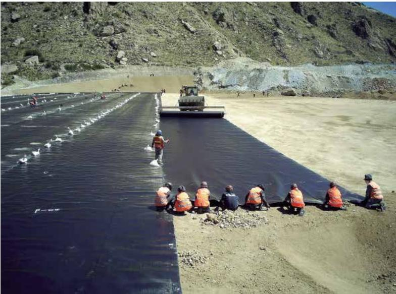
La geomembrana tiene muy buena durabilidad; es por eso que es muy usada en contacto con materiales peligrosos como por ejemplo, la impermeabilización de pads de lixiviación.
