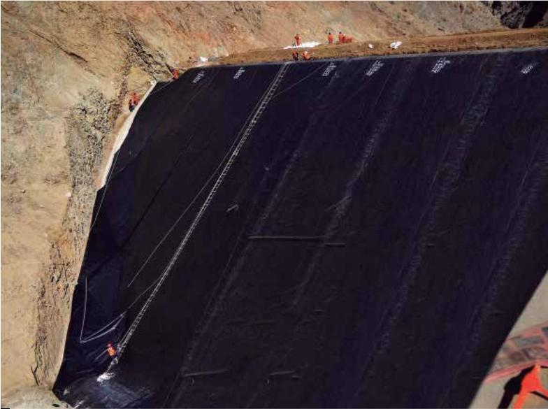
Los procesos de soldadura son de dos tipos: por termofusión, y otra por extrusión.
