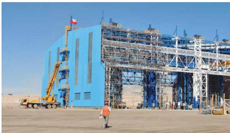
Durante la construcción se estima que se utilizaron 37,000 Tn de acero estructural, 185,000 m<sup>3</sup> de hormigón y 22,000 Tn de acero de refuerzo.
