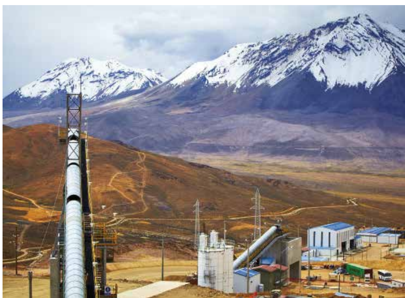
Ente las instalaciones de procesamiento se tienen una chancadora primaria y tolva de carga, la planta de absorción – desorción y la refinería
