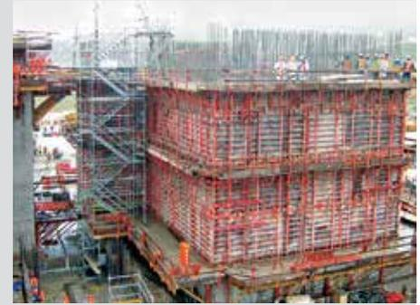
Encofrados modulados TRIO para presiones de 80 kN/m<sup>2</sup> y escaleras de acceso ROSETT de 1,00 m de ancho.
