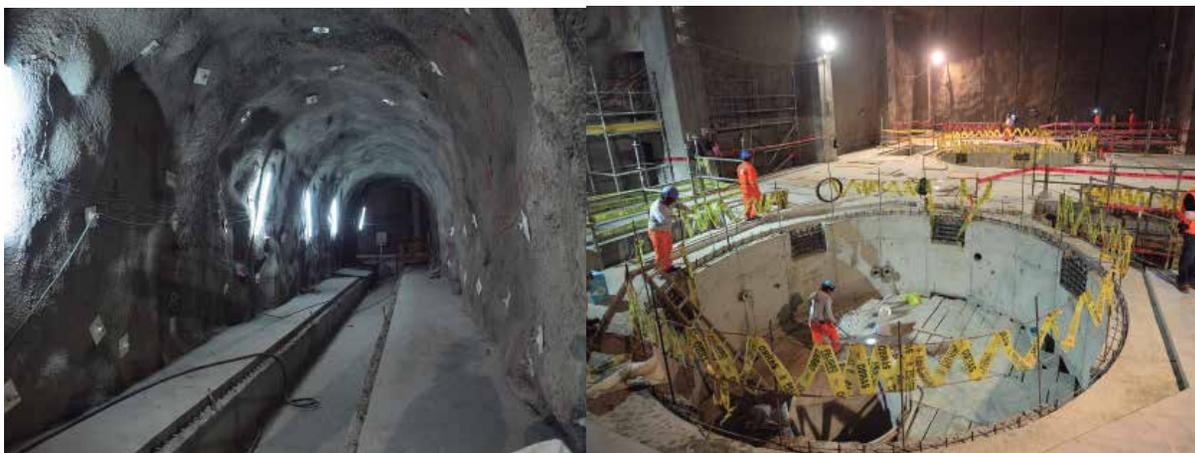
La casa de máquinas tiene una longitud de 15.70 m, un ancho de 41.7 m y una altura promedio de 20 m.
