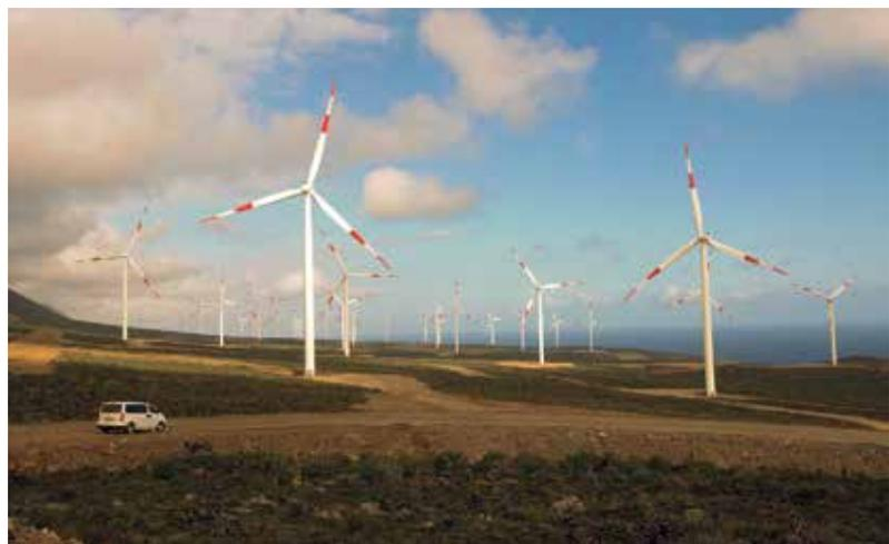
El proyecto que está emplazado en un terreno de 255 ha (considerando la línea de transmisión y subestación), cuenta con 50 aerogeneradores, donde cada uno de ellos tiene una capacidad de 2.3 MV.
