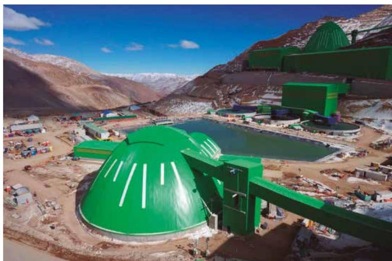
Los dos domos de mina Caserones están diseñados para tolerar ambientes duros, con cargas de nieve de hasta 800 kg/m<sup>2</sup> y presiones de viento de hasta 300 kg/m<sup>2</sup>. Gentileza Geométrica.
