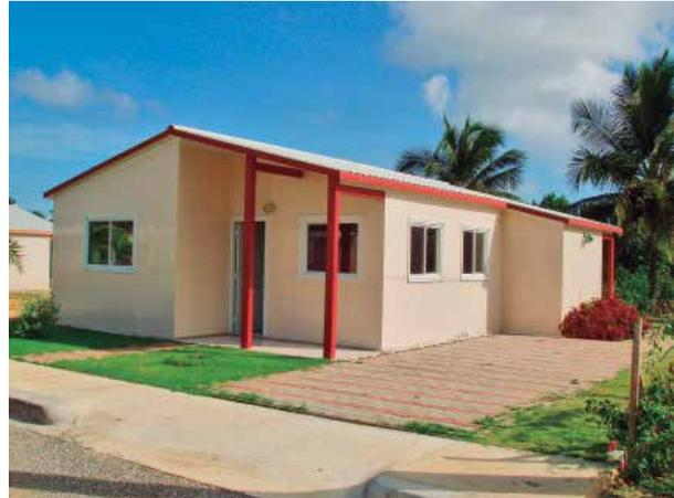
Módulo helitransportable, desarmable, económico y puede ser combinado con otros módulos.
