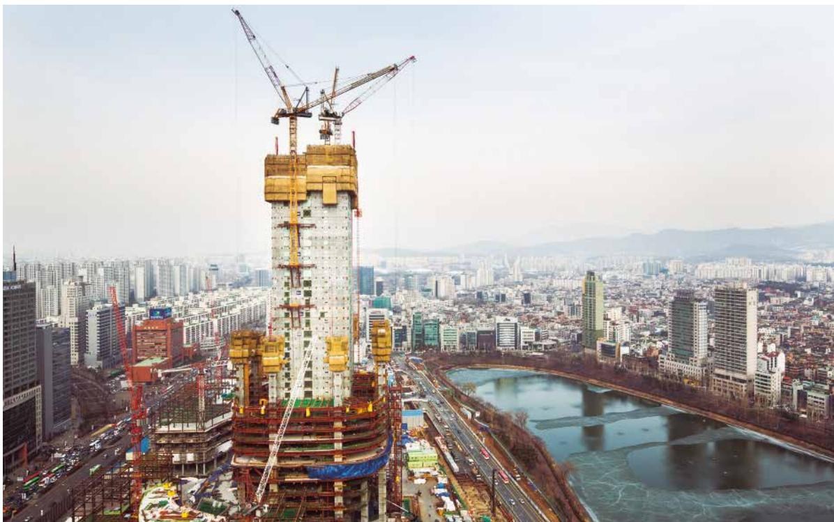
**S**e entiende por encofrado trepante aquel que se apoya sobre una estructura anclada en la tongada anterior a la que se pretende hormigonar. El desplazamiento de los elementos se realiza mediante grúas fijas o móviles. Un encofrado trepante está formado (según sean la geometría y condicionantes de la obra a ejecutar).
