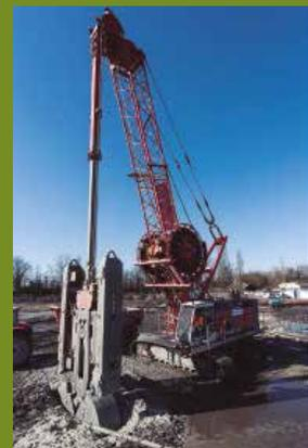
El proyecto llamado CUT OFF WALL – ANTAMINA, consiste en la construcción de un sistema de impermeabilización conformado por un muro pantalla de concreto plástico de 1 m de espesor y 30 m de profundidad, construido mediante el uso de equipos de pantallas. Asimismo contempla una cortina de inyecciones de impermeabilización en roca hasta una profundidad de 50 m por debajo del muro a construir.
