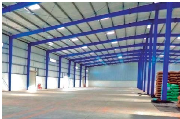
Los almacenes de materia prima son exclusivos para el producto terminado y su función es de regulador.
