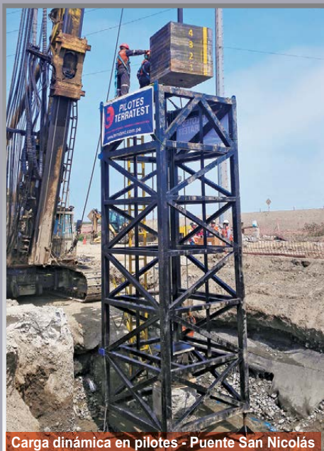
Carga dinámica en pilotes - Puente San Nicolás
