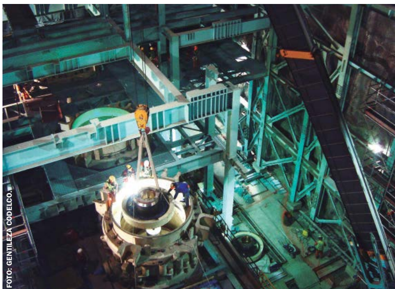
Para el montaje en caverna durante plan de desarrollo Andina fase 1, el chancador fue izado para ser montado a las bases de hormigón y posteriormente conectado a sistemas de cañerías y correas.
