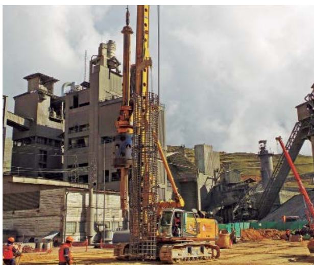
Planta de cemento Condorcocha UNACEM.
