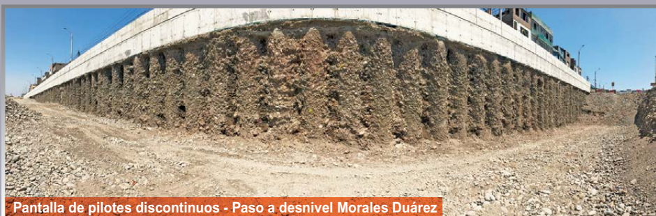
Pantalla de pilotes discontinuos - Paso a desnivel Morales Duárez
