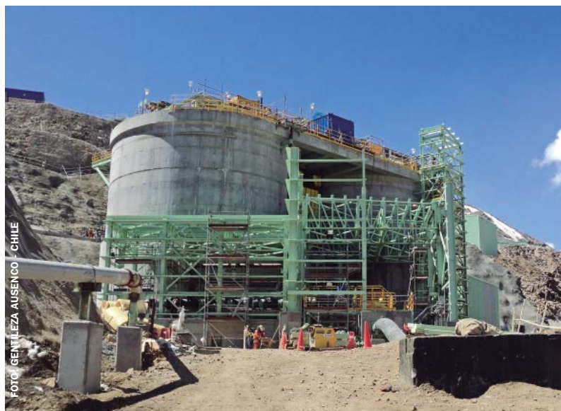
Para el montaje de los estanques de almacenamiento de pulpa, se realizaron las fundaciones de ambas estructuras con unión fija a la losa de fundación de espesor constante igual a 150 cm, unidos entre sí por una losa a nivel de coronamiento de 25 cm de espesor.
