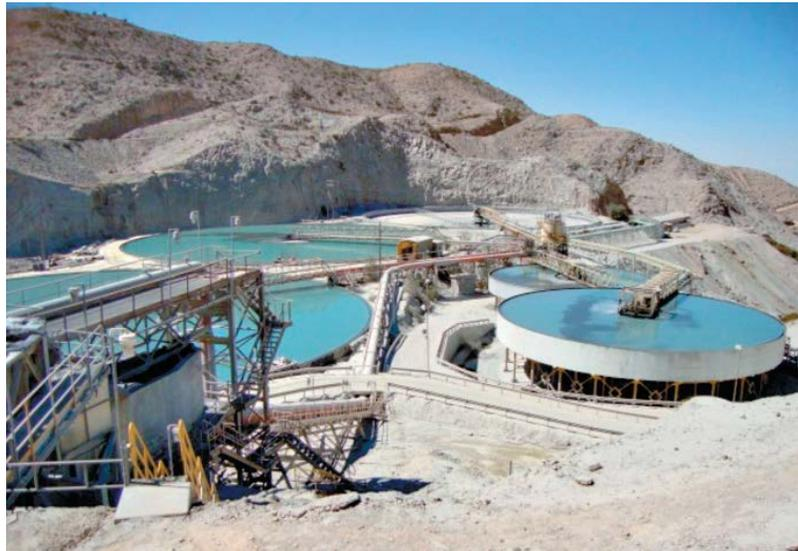
Este proyecto consiste en hacer una nueva planta concentradora con capacidad de molienda igual a la planta existente, 60,000 Tn por día de mineral, lo que producirá 100,000 Tn de cobre fino al año.
