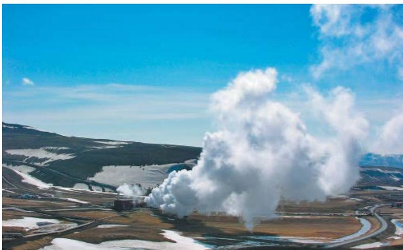
La planta Cerro Pabellón se compone de dos unidades de 24 MW con una capacidad instalada total bruta de 48 MW y será capaz de producir cerca de 340 GWh al año, equivalente a las necesidades de consumo de unos 165.000 hogares.
