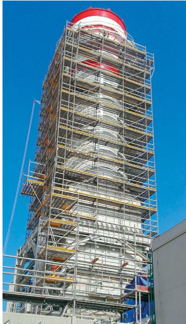
Modulación de andamios para adecuarse a geometría de chimeneas en el montaje de Centrales térmicas.
