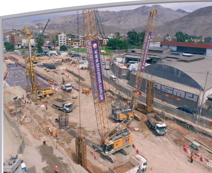
Muro Pantalla, Pilotes y Pilas-Pilotes - Línea 2 del Metro de Lima
