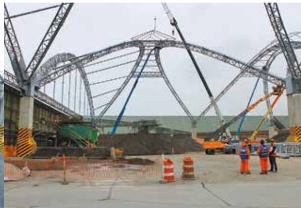
La finalidad de este proyecto es el mantener estructuras tensionadas, además las estructuras tienen un equilibrio que generan pendientes que permiten un drenaje natural ante la presencia de lluvias y a la vez con el tipo de membrana que se ha usado permite el paso de luz.
