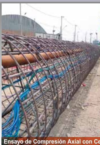
Ensayo de Compresión Axial con Celda Osterberg - Línea 2 Metro de Lima
