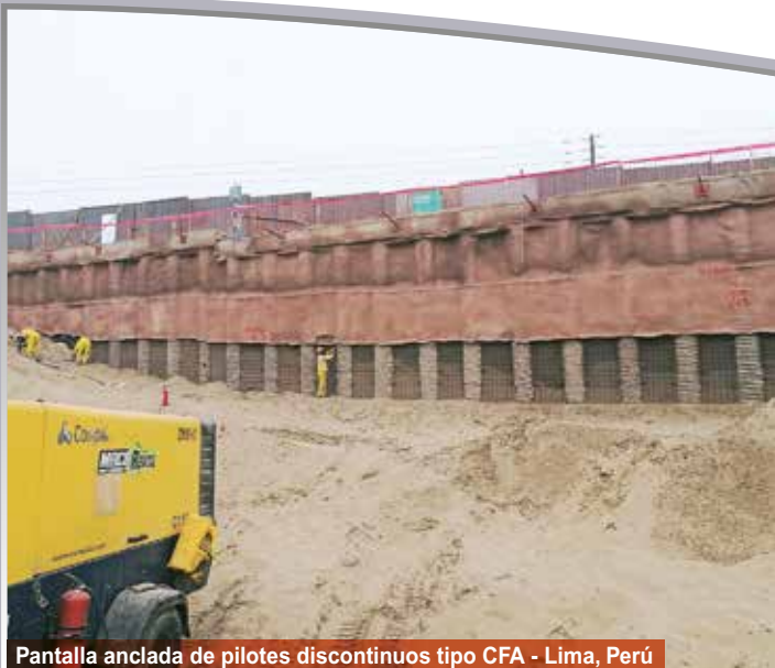
Pantalla anclada de pilotes discontinuos tipo CFA - Lima, Perú
