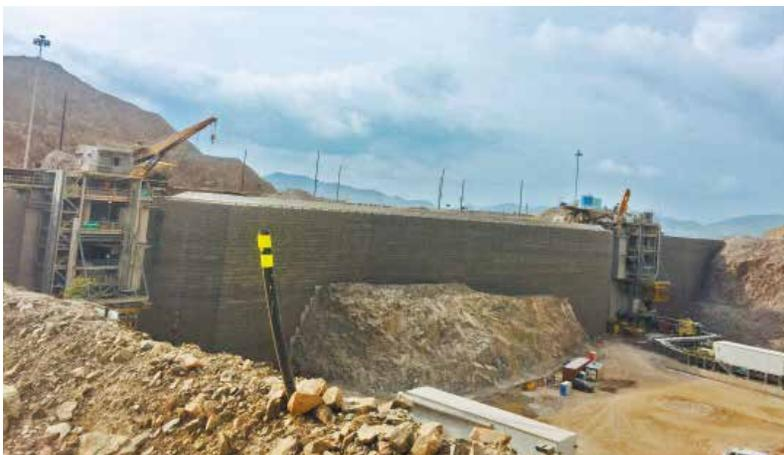
Los muros GeoTrel™ están reforzados con cintas geosintéticas (GeoStrap®) conectadas a unas mallas de acero electrosoldado de alta calidad revestidas para su protección contra la corrosión, mallas que sirven de paramento frontal de la estructura.
